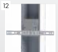
12 Elementy wzmacniające konstrukcję ościeżnicy z kotwami montażowymi Ościeżnica 15/54
