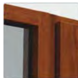
ŁĄCZENIE NAŚWIETLA Z OŚCIEŻNICĄ - GÓRNY RÓG
