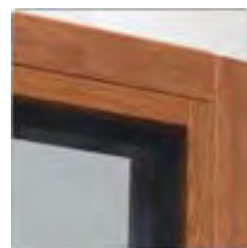
ŁĄCZENIE NAŚWIETLA OD STRONY WEWNĘTRZNEJ
